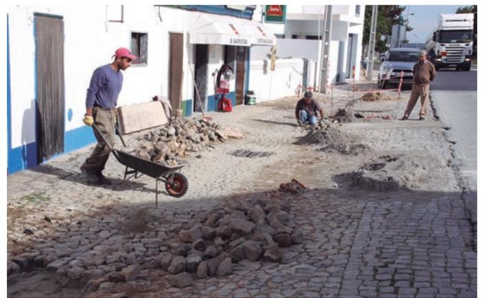
Montagem de coletor de águas pluviais e melhoramento da calçada, na Rua 25 de Abril, em Aguiar - 2012
