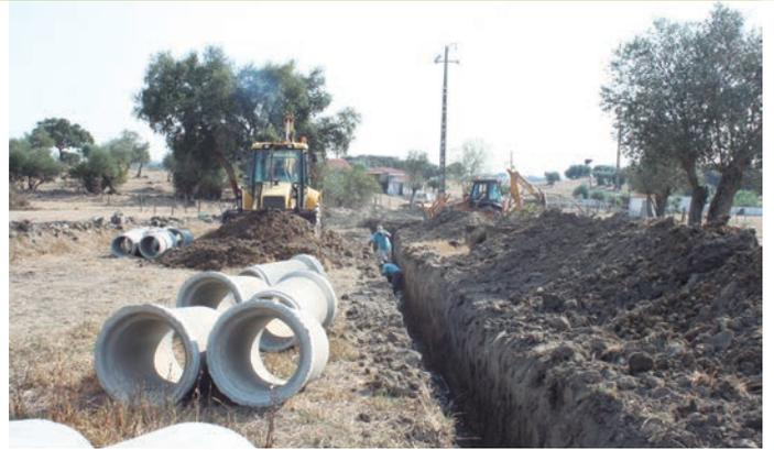
Montagem de coletor de águas pluviais numa extensão de 100m, em Aguiar - 2011
