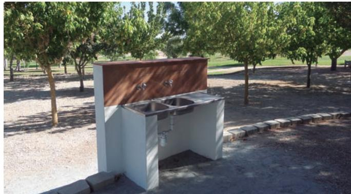
Construiu-se uma estrutura de apoio no parque de merendas situado na Quinta da Joana, em Viana do Alentejo. A estrutura consiste na criação de um ponto de água e instalação de lava loiças e uma fossa séptica. A obra efetuada por trabalhadores do município vem suprir uma necessidade dos utilizadores do parque.
