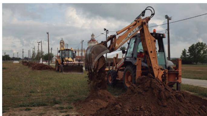
Procedeu-se recentemente à substituição da conduta entre o Cemitério e a Sr.ª D'Aires. A nova conduta vai evitar os desperdícios de água resultantes das várias ruturas que ocorriam frequentemente. A obra foi efetuada por trabalhadores do município.
