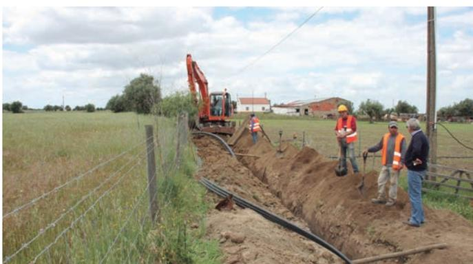
A Águas Públicas do Alentejo, S.A. está a proceder à substituição de troço de conduta de Viana do Alentejo - Aguiar. Esta substituição deve-se à necessidade de melhorar o respetivo abastecimento de água.
