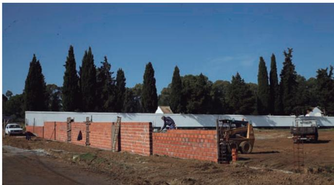
Continuam a bom ritmo as obras de ampliação do Cemitério de Alcáçovas, efetuadas por administração direta. A intervenção engloba a construção de esgotos domésticos e pluviais, saneamento, rede de águas e arruamentos. A obra permitirá fazer face ao problema da falta de espaço para as sepulturas.
