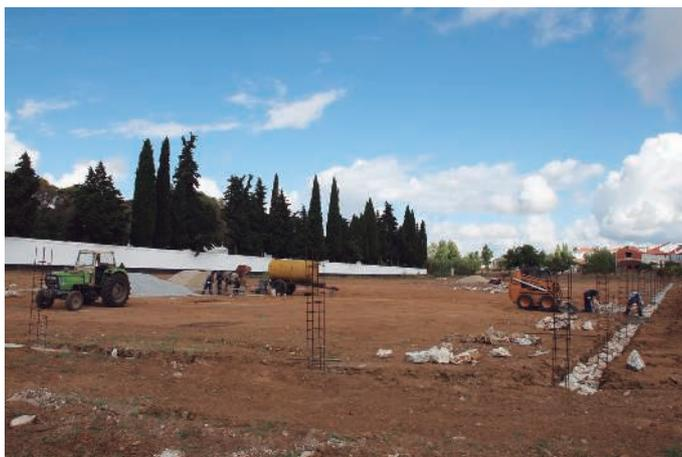
Continuam as obras de ampliação do Cemitério de Alcáçovas. Efetuada por trabalhadores do Município, a intervenção inclui a construção de esgotos domésticos e pluviais, saneamento, rede de águas e arruamentos. A obra permitirá aumentar a capacidade do cemitério e fazer face ao problema da falta de espaço para as sepulturas.
