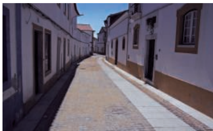
Rua Prof. Manuel Dâmaso Prates após a conclusão da intervenção
