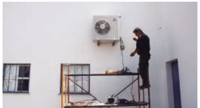
Instalação de aparelhos de ar condicionado
