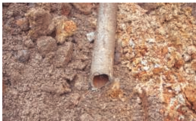
Tubagem antiga deteriorada
