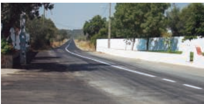
Sinalização horizontal na Estrada de Santa Catarina
