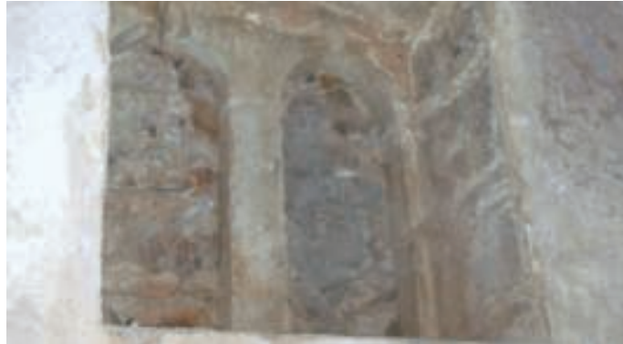
Fotografia 2 - Janela dupla, tendo no meio uma pequena coluna a que se chama mainel, existente na parede Nordeste da antiga ermida de Nossa Senhora da Conceição, o actual Posto de Turismo. Atrás pode ver-se, fechando-a, a muralha do Castelo.
