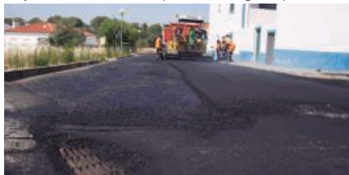
Pavimentação no Loteamento Chão do Mocho em Alcáçovas
