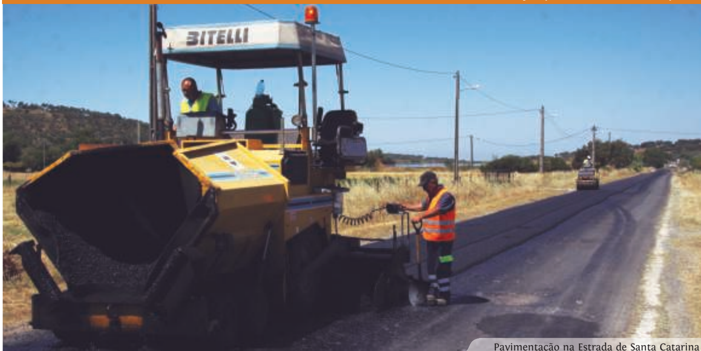
Pavimentação na Estrada de Santa Catarina
