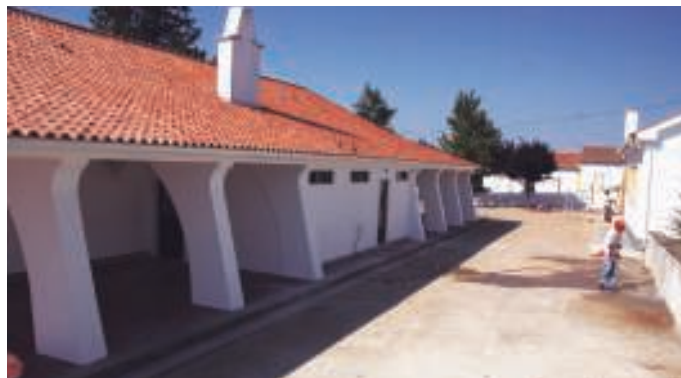
Vista do alçado posterior após a intervenção
