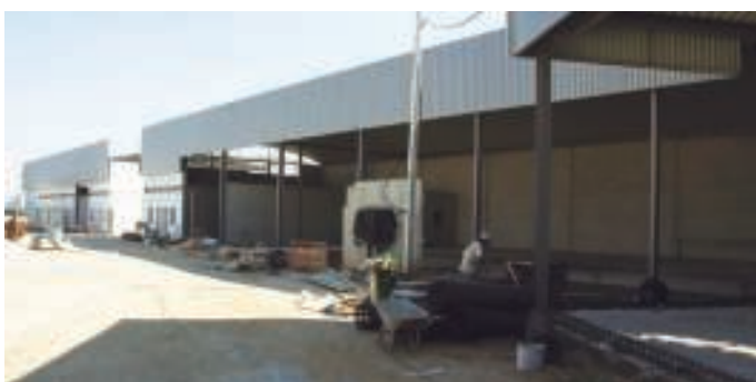
Obras encontram-se na sua fase final
