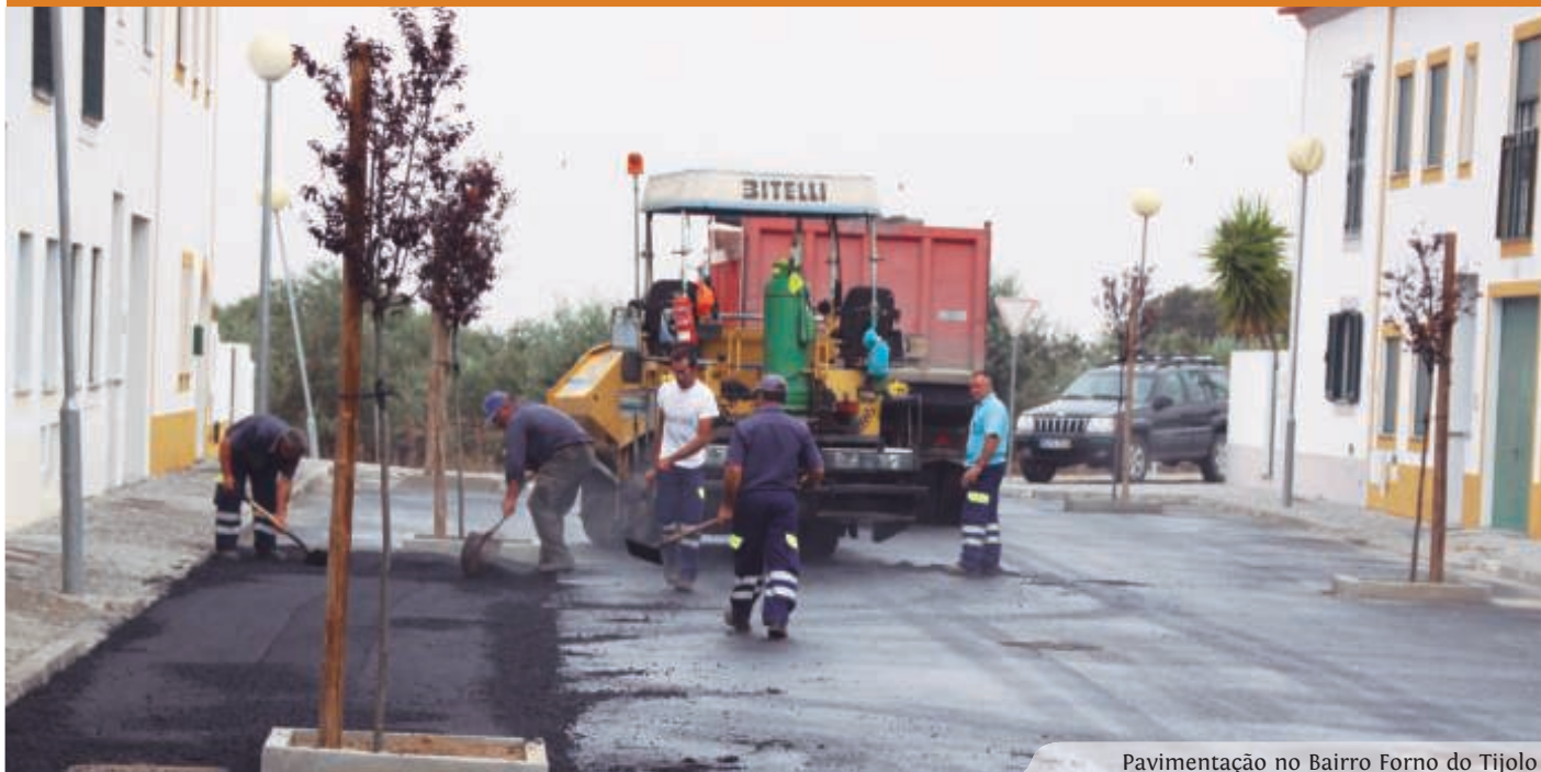
Pavimentação no Bairro Forno do Tijolo
