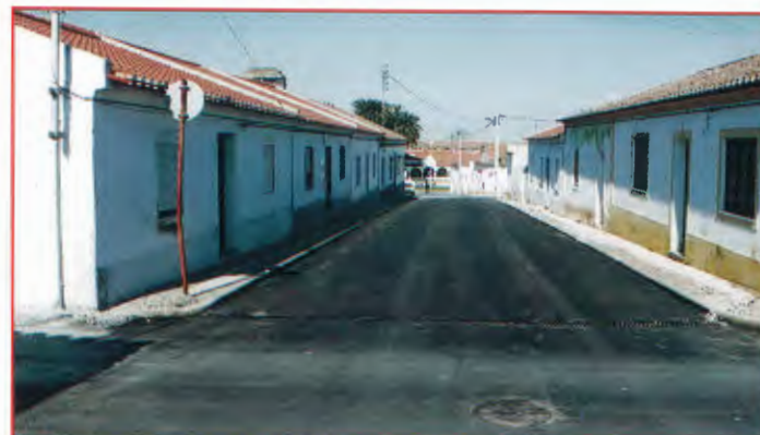
Pluviais nas ruas D.ª Ana Cabral e Progresso Viana
