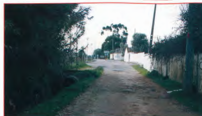
Colector de Esgotos da Azinhaga da Barca Viana
