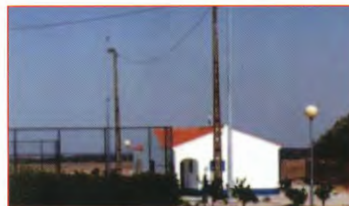
Iluminação do Polidesportivo Aguiar
