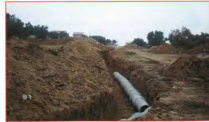
Novas Condutas de Água Alcáçovas
