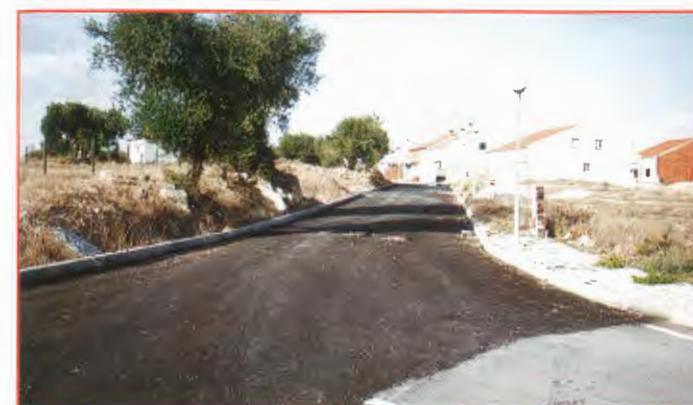
Asfaltamento na Fazenda da Anta Aguiar
