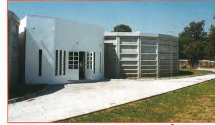
Novo Reservatório de Água Alcáçovas
