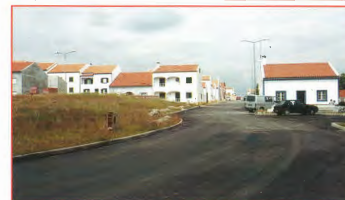
Asfaltamento no B.º Chão do Mocho - Alcáçovas
