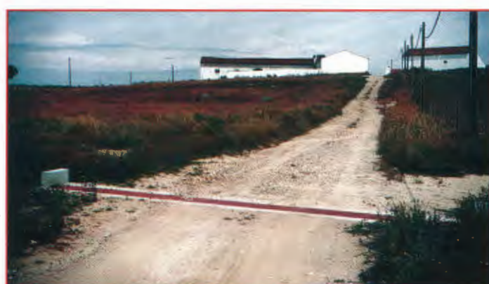
Pluviais na Azinhaga dos Casões Aguiar
