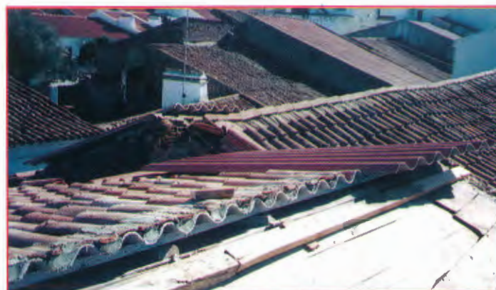
Novo Telhado da Sede A.C.R.A. Alcáçovas
