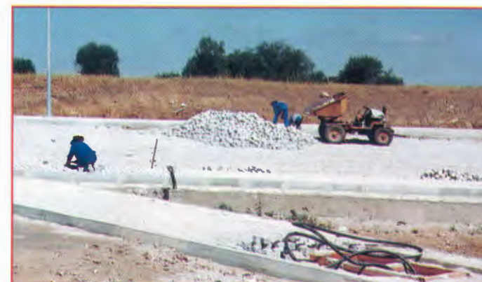
Arranjos Junto ao Polidesportivo Coberto - Viana
