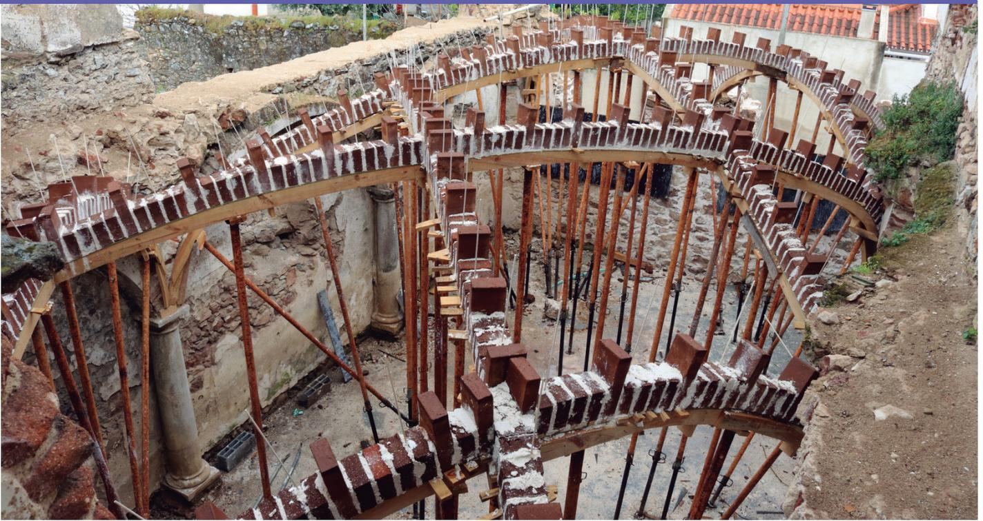
Fotografia 1 - Aspecto da reconstrução das nervuras da abóbada de uma das salas do lado nascente do Mosteiro do Bom Jesus de Viana do Alentejo.
