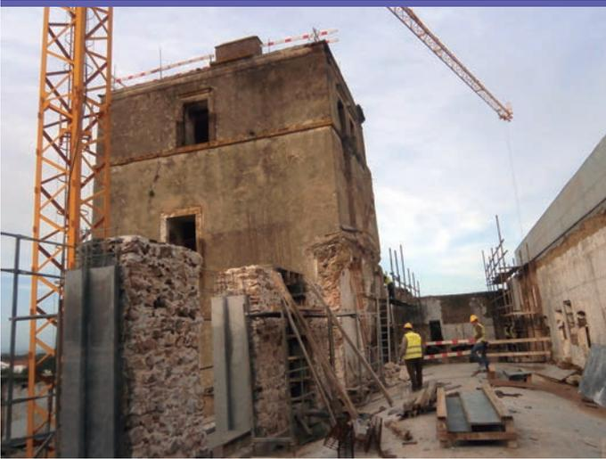
Fotografia 2 - A “torre da priora” em cujo segundo piso, pensamos, estava localizada a biblioteca e arquivo da congregação. As paredes do “dormitório velho”, em primeiro plano, estão a ser reconstruídas, usando-se frequentemente as mesmas técnicas e materiais de há quinhentos anos.
