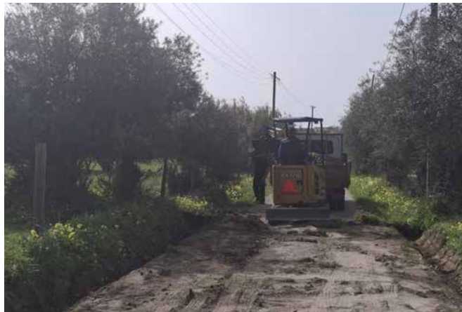
Melhoria nos sistemas de drenagens
