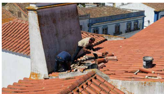
Intervenção na cobertura do Paço dos Henriques
