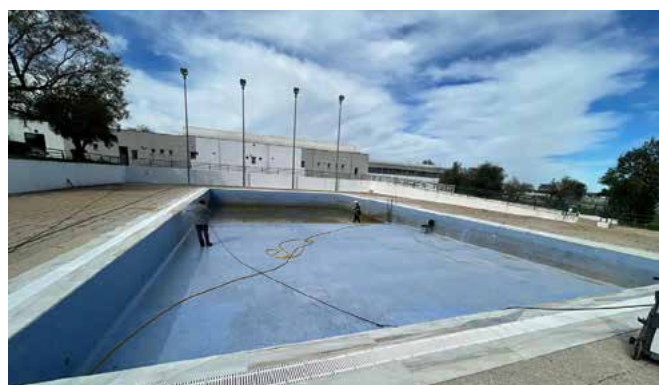
Verificação técnica para posterior reparação na Piscina de Viana
