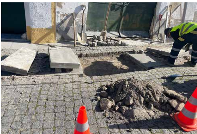
Substituição de lajetas no centro histórico
