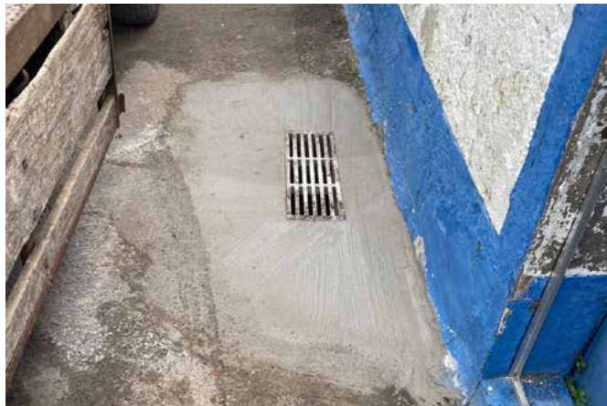
Construção de sumidouros
