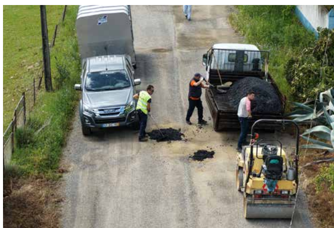
Trabalhos de reparação de estradas municipais
