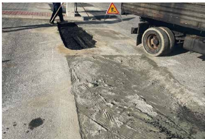
Aplicação de betuminosos em arruamentos
